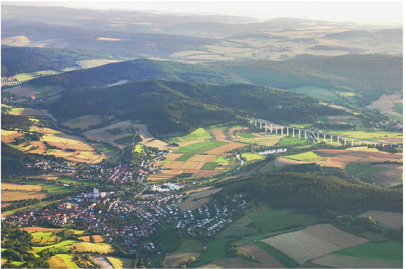
Blick ins Fuldata mit ICE-Brücke und Wichte (links) und Binsförth (rechts)
