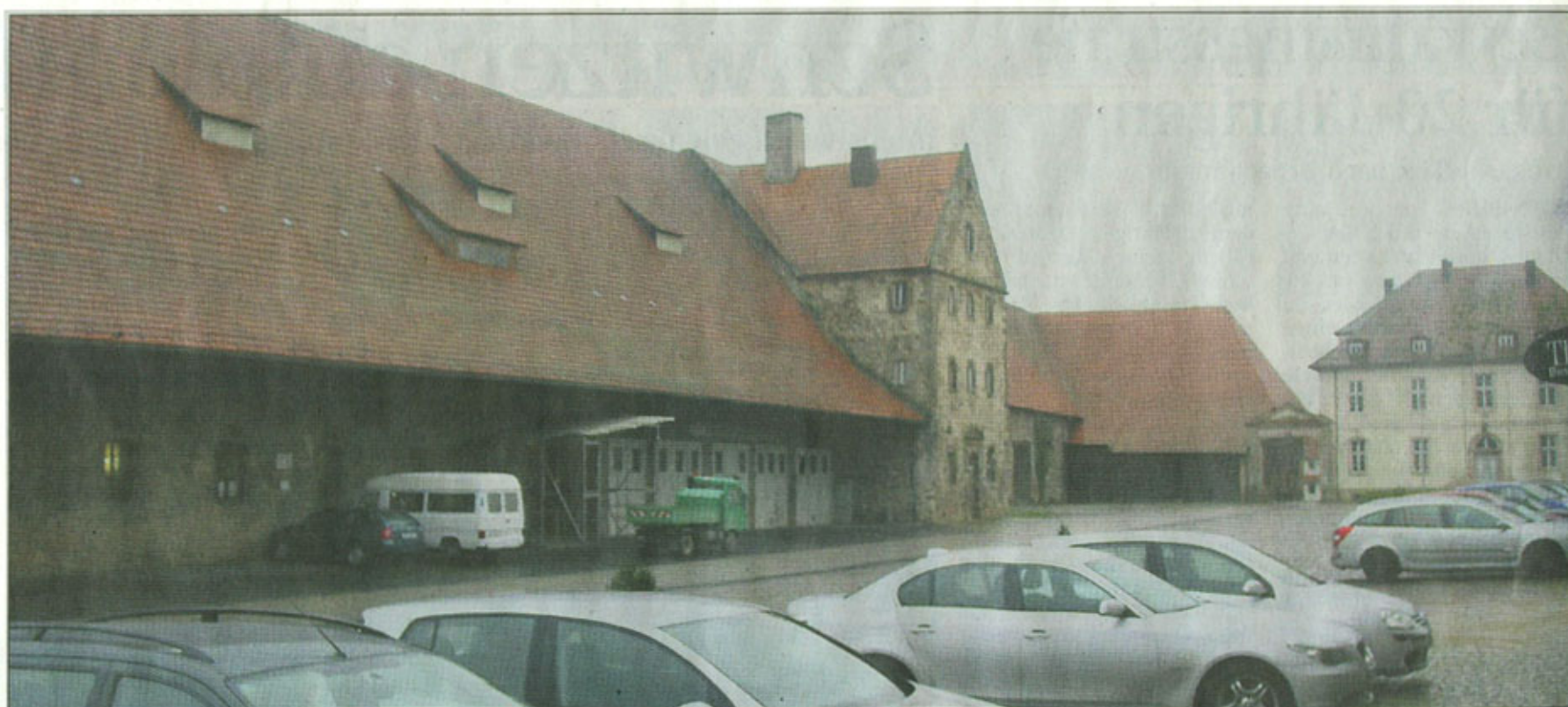
Blick in den Domänenhof: Die B. Braun Melsungen AG wird die zur Klosteranlage gehörenden Gebäude zu einem Seminar- und Tagungszentrum umbauen. Ein Hotel mit 130 Betten soll neu gebaut werden.
