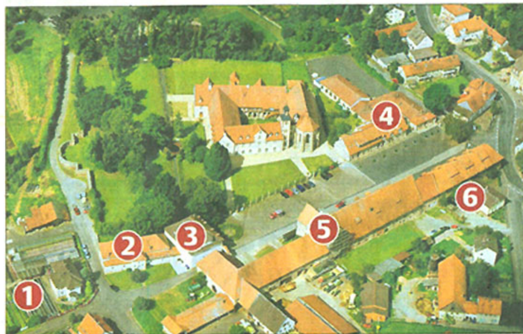
Auf einen Blick: links die ehemalige Gärtnerei Salzmann (1), gleich rechts neben der kleinen Straße die Orangerie (2), angrenzend das Herrenhaus (3). Rechts neben dem Klosterkomplex der einstige Stall, später Brennerei und jetzige Mörscher Verwaltungssitz (4) mit angrenzendem Bauhof. Das langgestreckte Gebäude mit dem roten Dach besteht aus Burggrafenhaus (5), Stallungen und Scheune. Das alles steht für Umbau und Sanierung, auch Abriss an. Parkplätze (6) statt des Zahnarztzhauses.
