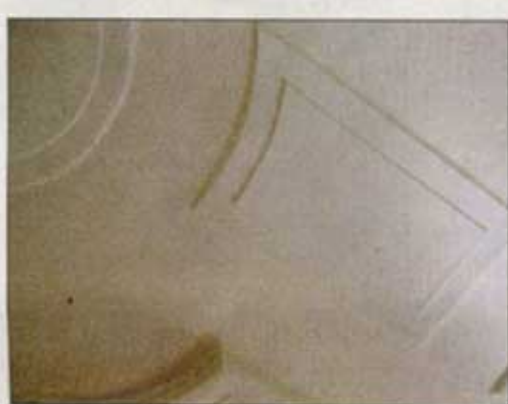
Deckenschmuck: Die Stuckdecke im repräsentativsten Zimmer ist gut erhalten.
