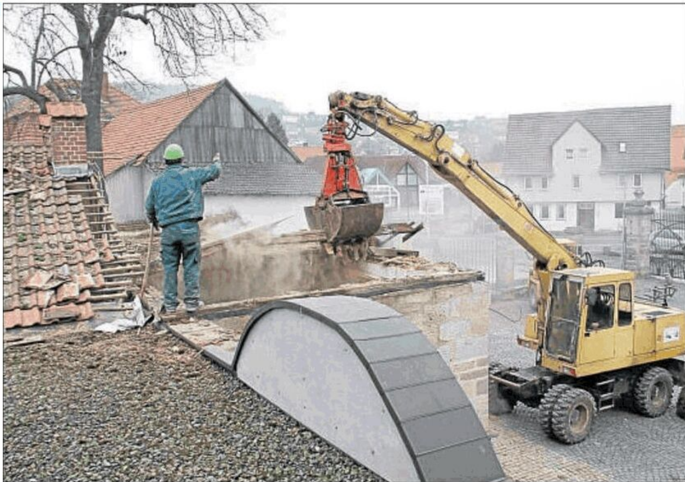
Der Abriss hat begonnen: Bauarbeiter tragen den verfaulten Dachstuhl des Wachhauses an der Zufahrt zum Domänen Gelände ab. Als Nächstes kommt das Nachbargebäude dran, das bislang ebenfalls von der Gemeindeverwaltung genutzt wurde.
