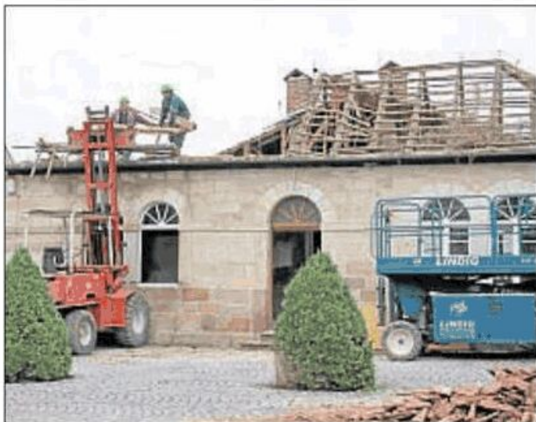
Vorsichtiger Abbau: Schutt und Ziegeln werden entsorgt, die Steine, Türen und Fenster eingelagert.
