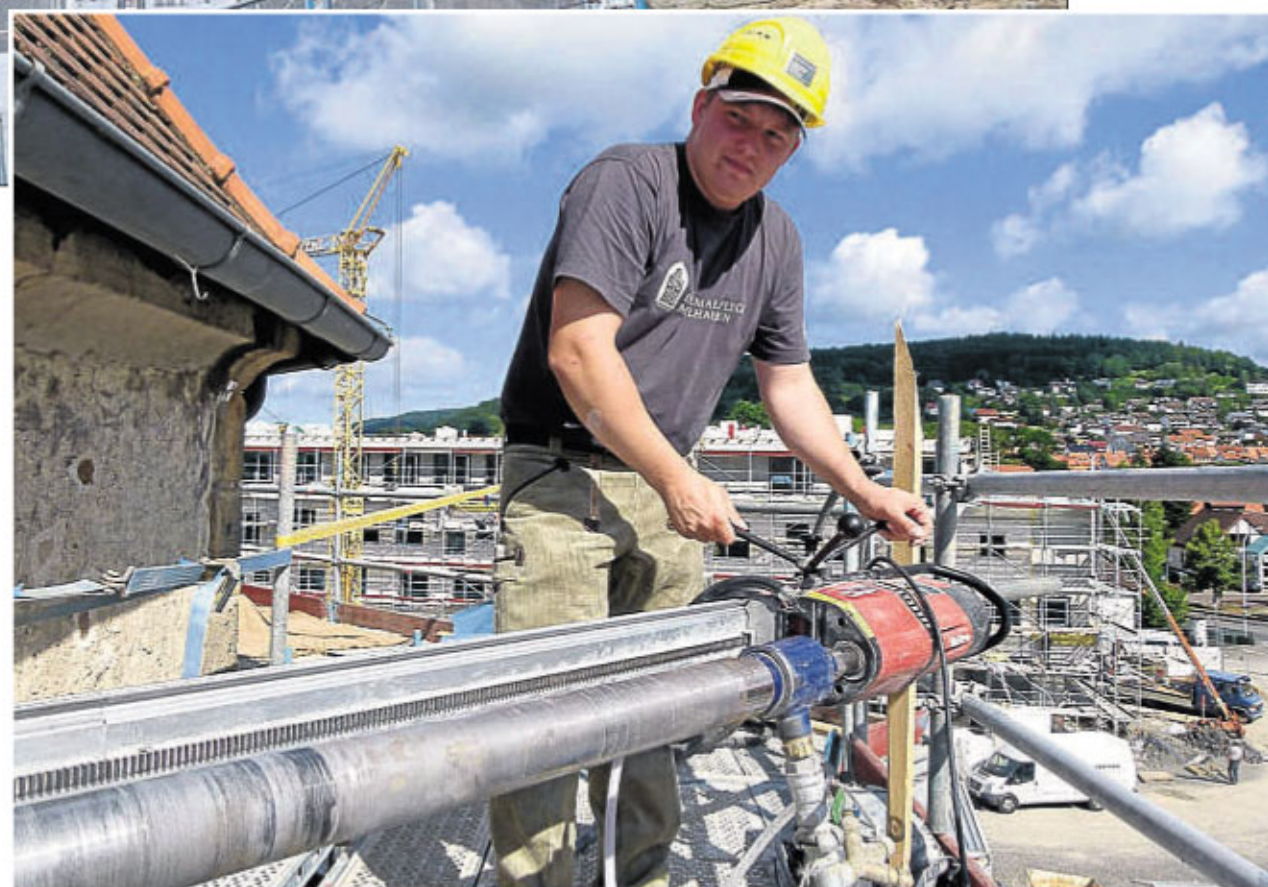
Gebohrt wird im Schneckentempo: Frank Hoppe von der Firma Denkmalpflege Mühlhausen betätigt den Bohrer. In das Loch kommen ein Strumpfanker aus Edelstahl und Spezialmörtel um das rissige Mauerwerk zu sichern.
