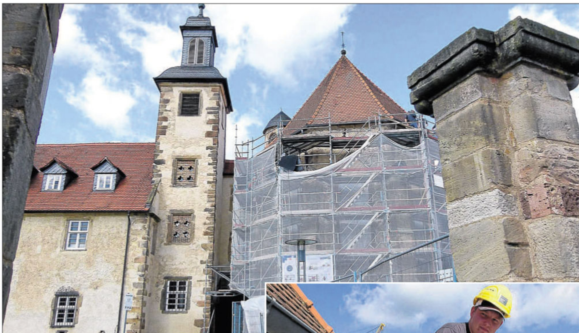
Baustelle Klosterkirche: So wie der Putz unten am Gebäude links im Bild soll der der zurzeit eingerüsteten Kirche aussehen.
