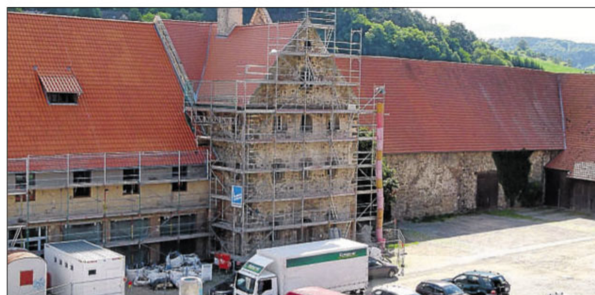
Baustelle B. Braun-Seminarzentrum: Außen werden die Domänengebäude den gleichen Putz erhalten wie Kloster und Kirche.
