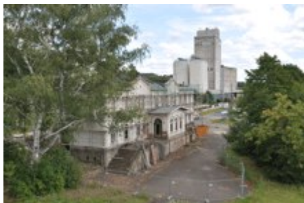
Bahnhof Altmorschen vor der Sanierung
