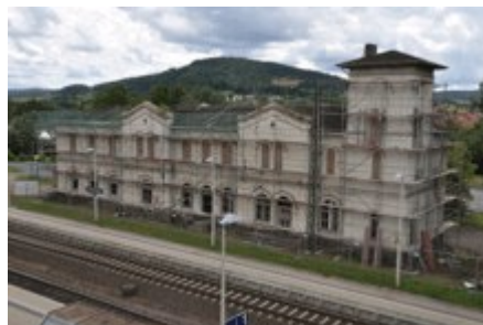
Bahnhof Altmorschen vor der Sanierung
