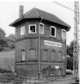
Stellwerk am ehem. Bahnübergang nach Heina.
