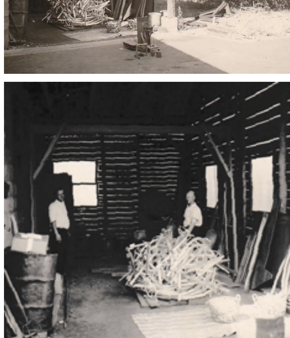
Beizraum (links) und Lagerung verzinkter Teile (rechts)
