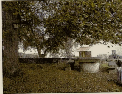
Lindenplatz: Die Mauer muss saniert, der Bereich gestaltet werden.
