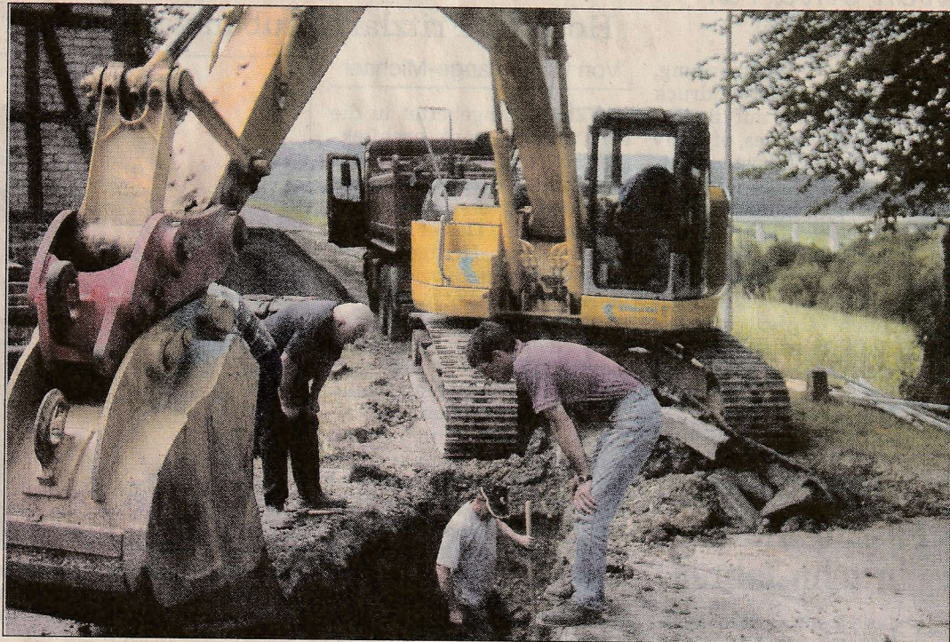
Hier wird im Untergrund gearbeitet: Lkw-Fahrer Peter Wiese, Bauführer Lars Mangold und Polier Ernst Hoßbach (von links) an der Baustelle.
