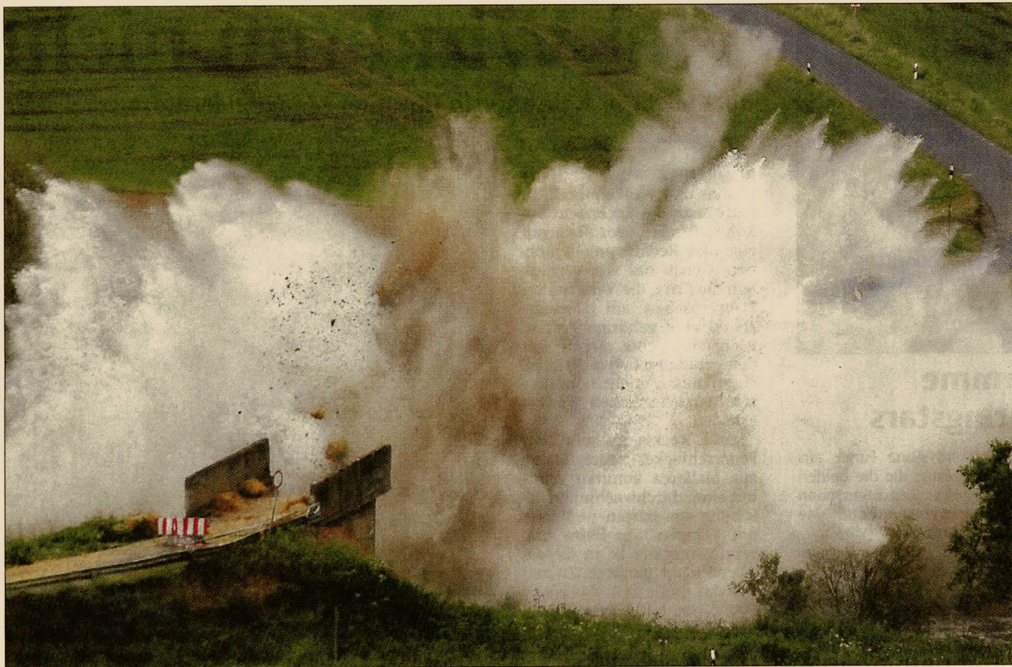
77 Sprenglöcher zündeten innerhalb weniger Sekunden: Die Fuldastraße bei Binsförth wurde am Sonntag gesprengt.
