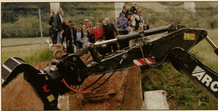
Nach der Sprengung: Bagger fischen die Trümmer aus der Fulda, Schaulustige stehen auf dem Brückenaufsatz.
