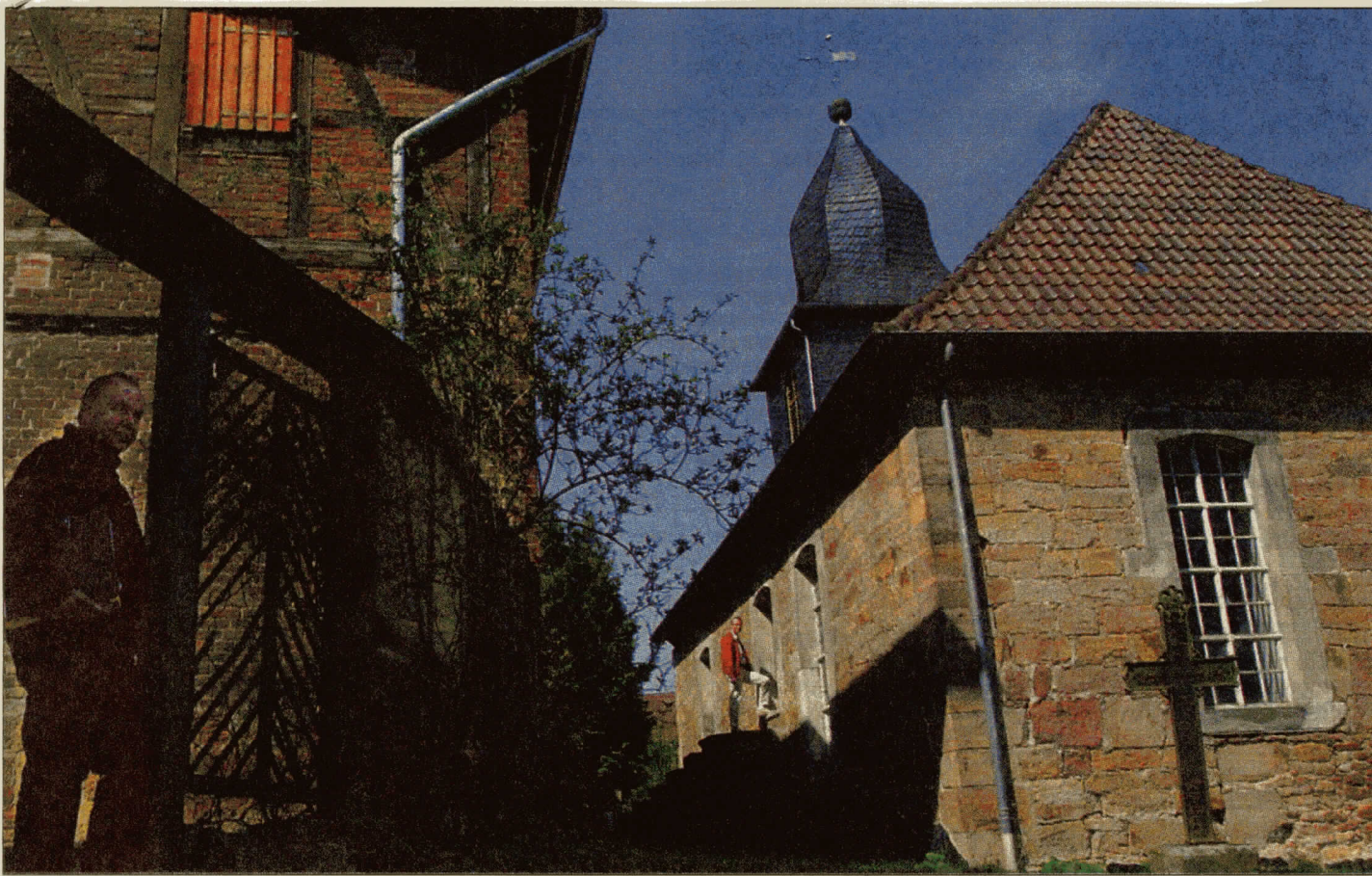
Hintereingang: Hier entlang ging der Patron vom Rittergut Binsförth in die Kirche. Architekt Helmut Spitze (links) und Pfarrer Bernd Knobel (rechts), der schon auf der Treppe vor dem Nebeneingang der Kirche steht, machen's vor. So konnten die Herrschaften direkt auf ihre Empore gelangen, ohne durch die Reihen des gemeinen Volkes zu gehen. FOTOS: BRÜCKMANN
