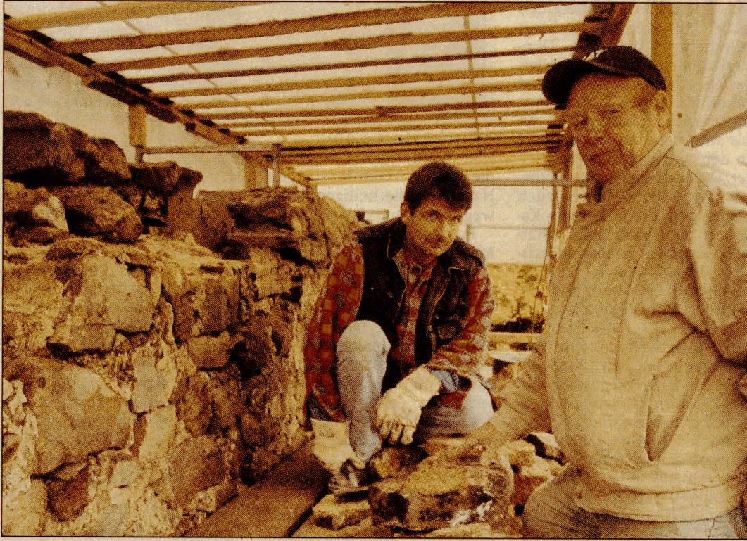
Arbeiten Hand in Hand: Unter der Anleitung des Rentners Horst Hast (rechts), einst Vorarbeiter, sanieren Ein-Euro-Kräfte wie Matthias Seifert die Klostermauer.
