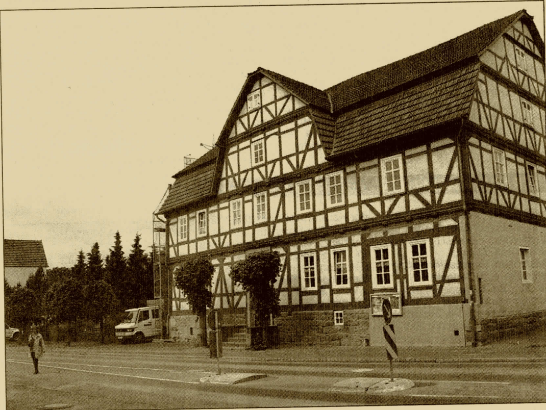
Das Pfarrhaus in Altmorschen wird derzeit von Grund auf renoviert. Bis zum September sollen die Arbeiten abgeschlossen sein. (Foto: Schmidtkunz)
