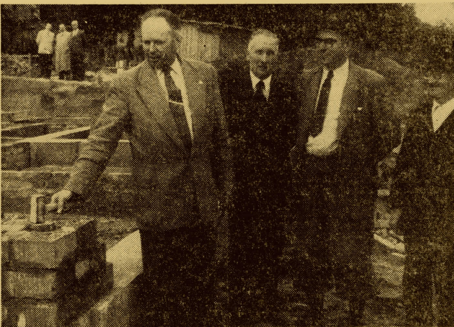
Bürgermeister Jakob Frankfurth vollzieht die Grundsteinlegung mit den symbolischen drei Hammerschlägen. (Aufn.: HN/b)
