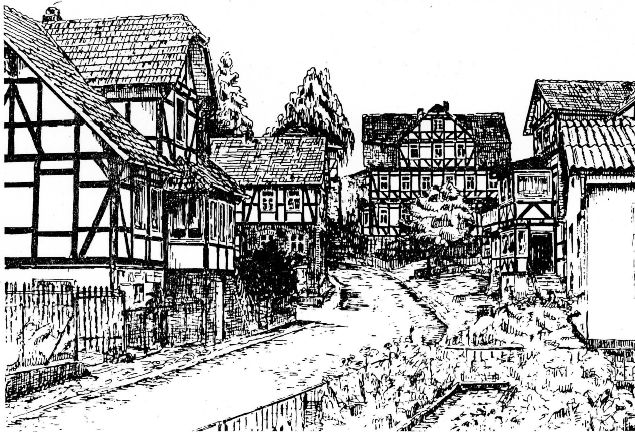
Altmorschen: Blick auf die alte Schule. Beispiel für Fachwerkbauten, die einen Raum bilden. An weiteren Stellen müssen – so heißt es – solche Bauten erhalten und restauriert werden. „Sie bringen eine vielfältige und charakteristische Raumqualität.“ Nur ein Beispiel aus dem Ortsteil. (Zeichnung: Meinl-nh)
