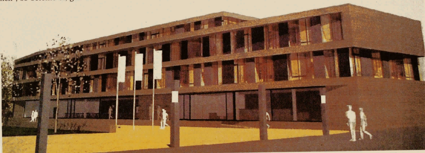
Für den Hotelneubau auf dem Gelände des Kloster Haydau soll ein Architekten-Wettbewerb ausgeschrieben werden. Doch so wie auf dieser Computerzeichnung von B.Braun könnte es einmal aussehen.
