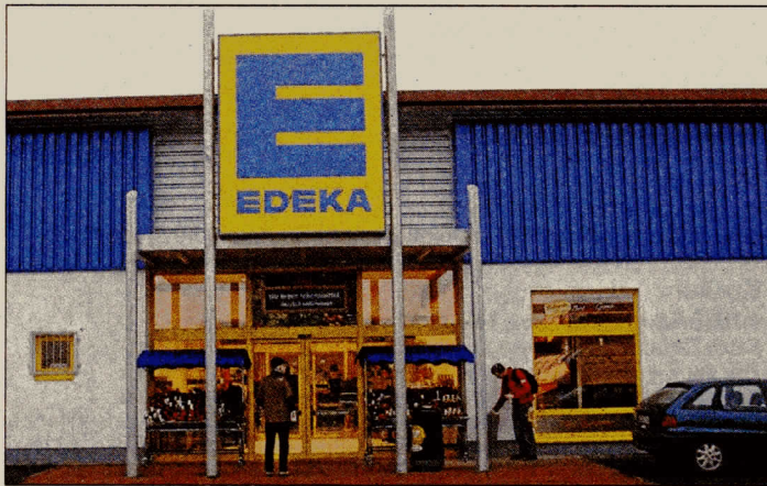
Erst im November eröffnet: Der neue Edeka-Markt an der Nürnberger Landstraße in Altmorschen.
