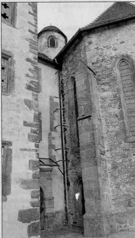
Die Mauersteine werden verputzt, die Ecksteine bleiben sichtbar. Links im Bild ein Stück Glockenturm des Kloster, rechts die Kirche.
