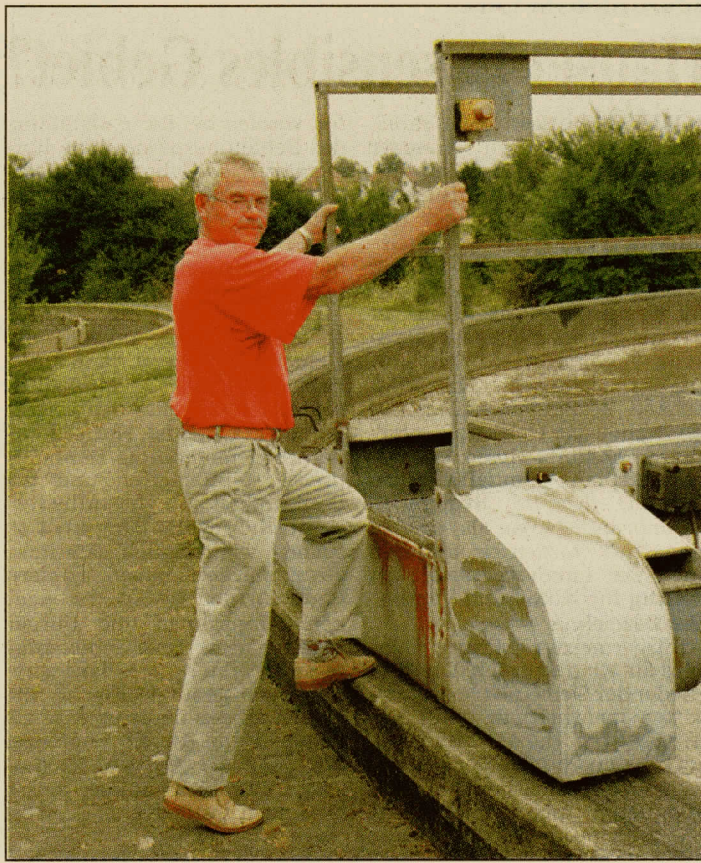
Inspektion des Belebungsbeckens von der Belüftungsbrücke aus. (Foto: Koch)
