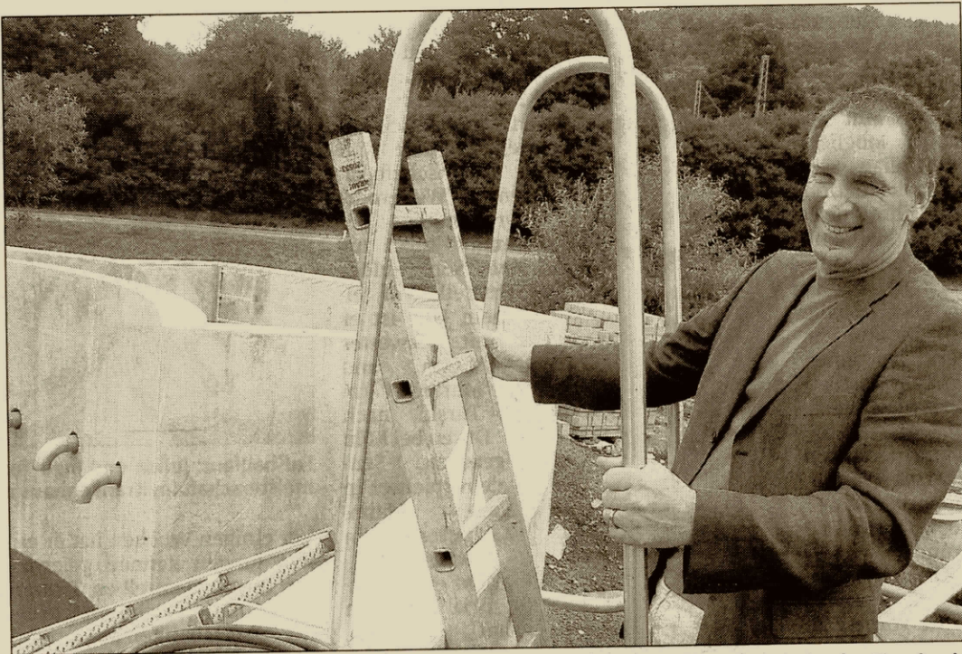
Nur bei starkem Regen gefüllt: Nicht Badegästen, sondern der Abwassermeisterin ist der Einstieg in das neue Regenrückhaltebecken vorbehalten, an dem Morschens Bürgermeister Herbert Wohlgemuth hier steht.
