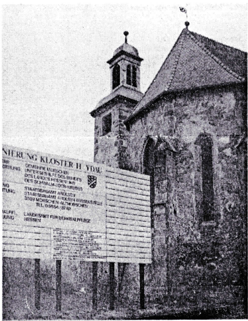
MIT MILLIONEN-AUFWAND wird zur Zeit das Kloster Haydau in Morschen saniert. Es soll künftig unter anderem für kulturelle Veranstaltungen genutzt werden.
