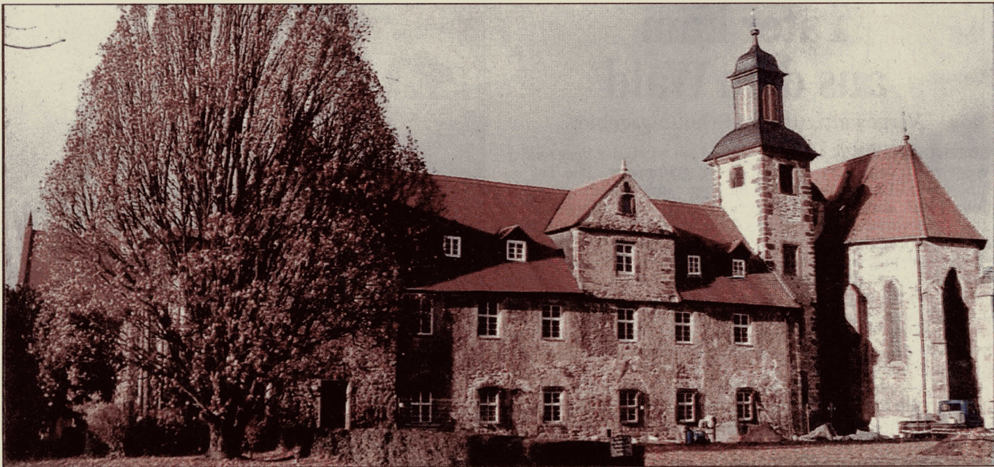
Strahlt über Morschen hinaus: Das Kloster Haydau, aufgenommen noch während der Sanierung.
