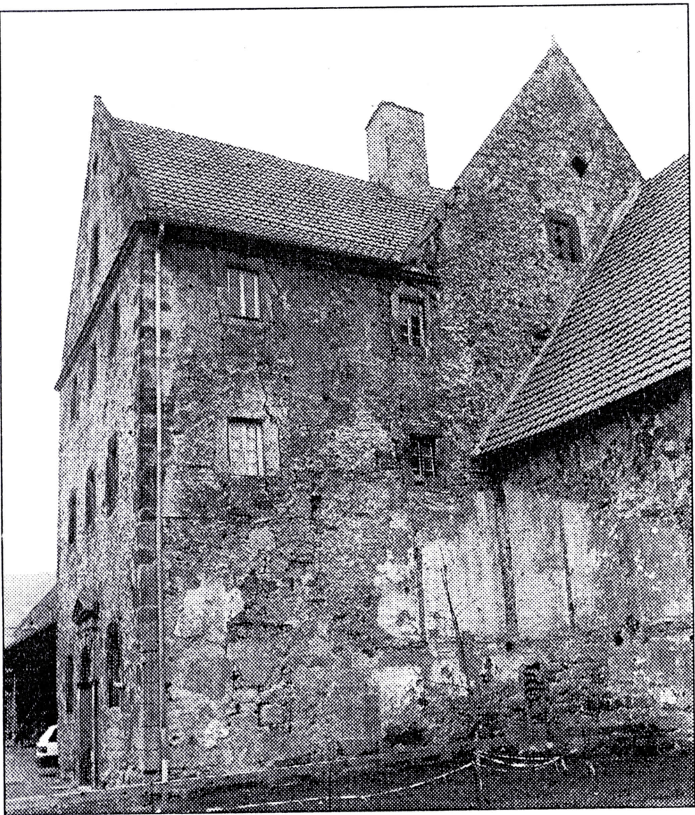
Putz und Dachsteine vom Burggrafenhaus in Altmorschen werden hergerichtet. (Foto: Koch)
