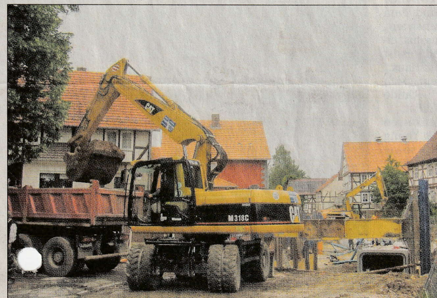
Baustelle Ortsdurchfahrt: Stück für Stück geht es durch Wichte. Dort wird in der Straße der Kastenkanal für den Bach verlegt, außerdem Wasser- und Kanalleitungen.
