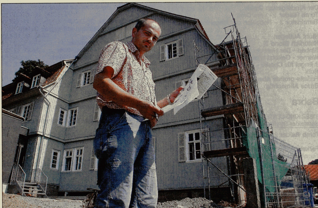
Wetterschutz in Taubenblau: Frank Caspar von der Homberger Garten- und Landschaftsbaufirma Lambrecht arbeitet auf dem Außengelände des alten Forsthauses, das derzeit aufwändig saniert wird. Die Westseite ist dem Wetter und den Abgasen besonders stark ausgesetzt. FOTO: HOCKE
