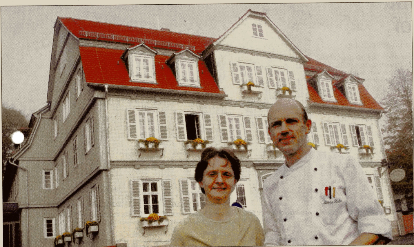
Die Pächter: Nach monatelangen Restaurierungsarbeiten wurde die Poststation Zum Alten Forstamt 2003 als Restaurant und Hotel eröffnet, Betreiber sind Berit und Thomas Raabe.
