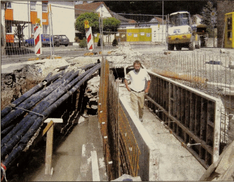
Neues Bett für den Eubach: Direkt vor dem Eingang zum Domänenhof wird ein neuer Kanal für den Eubach gebaut. Links im Bild: Die schwarzen Leitungen der Kanäle liegen sehr knapp unter der viel befahrenen Straße.
