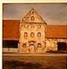
Das „Burggrafenhaus“ Zentrum 1998
